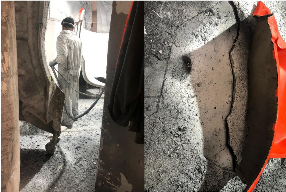
Ilustración 26. Desperdicio de Gelcoat en el piso. Fuente: CVNS Industrias SA de CV, 2022.
